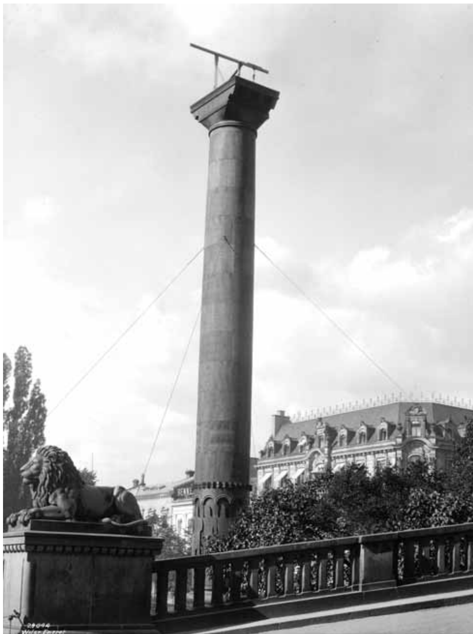
Рис. 2. Вид на колонну между зданием стортинга и одной из фигур льва
