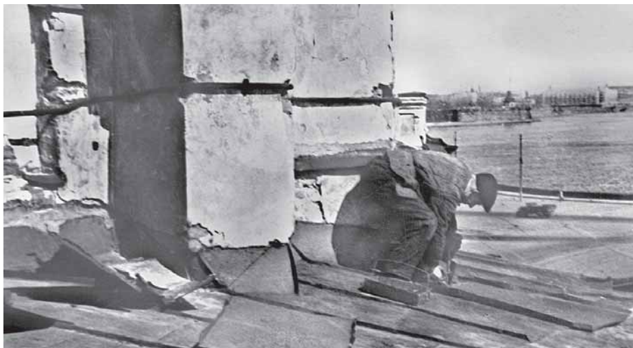
Заведующий Сектором Сибири А.А. Попов ремонтирует крышу.
