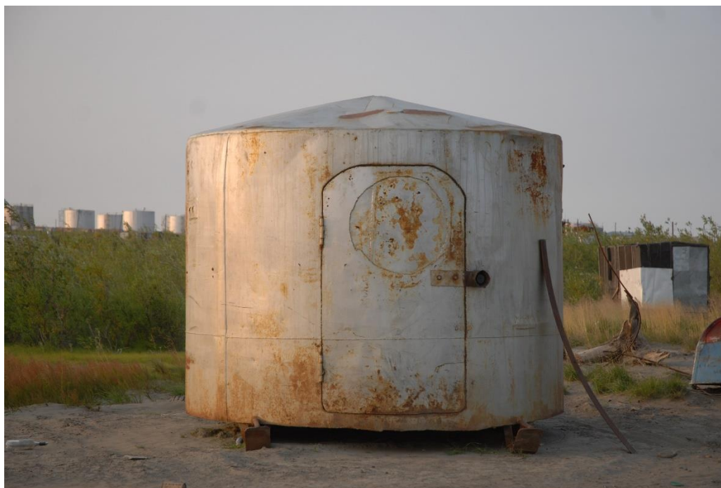
Рисунок 33. Чокурдах. Кладовка из распиленной цистерны, 2019 г.
