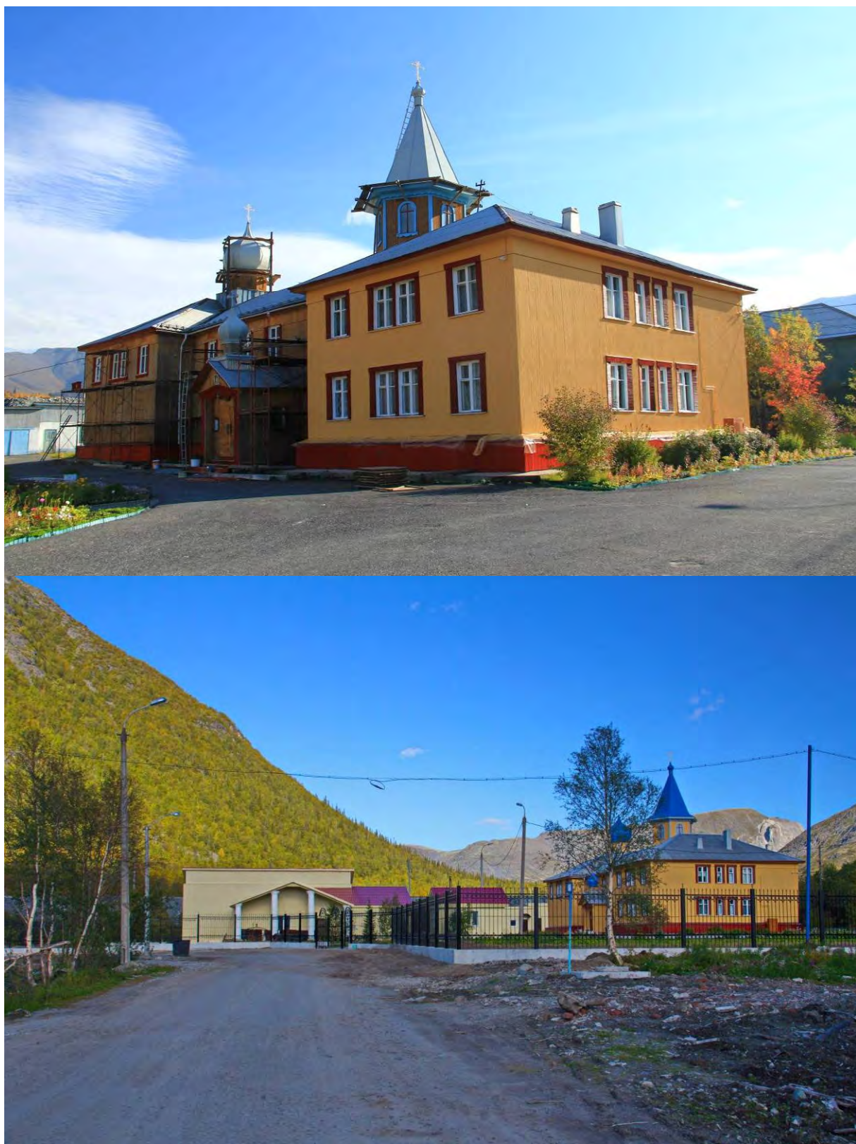
Рис. 6. Хибиногорский женский монастырь во время и после реконструкции. г. Кировск (поселок Юкспорр), 2013 г. Фото Д. А. Давыдова.
