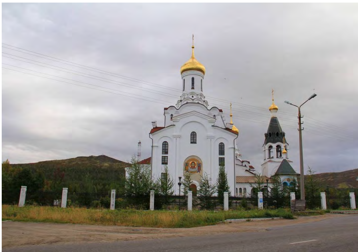
Рис. 16. Свято-Вознесенский кафедральный собор в г. Мончегорске (ул. Красноармейская), 2015 г. Фото Д. А. Давыдова.
