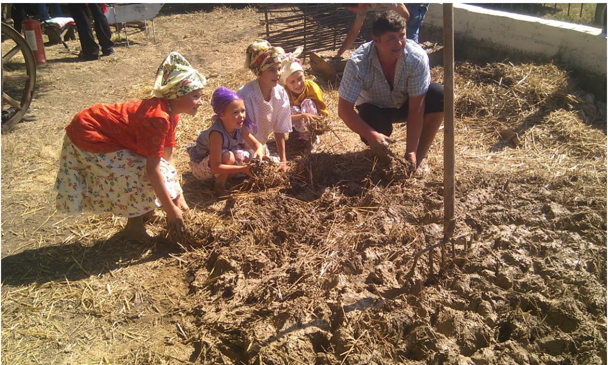
Фото № 26. Замес глины и изготовление саманов. Современная интерпретация клаки. (с. Гояны Дубоссарского района 2013 г.)
