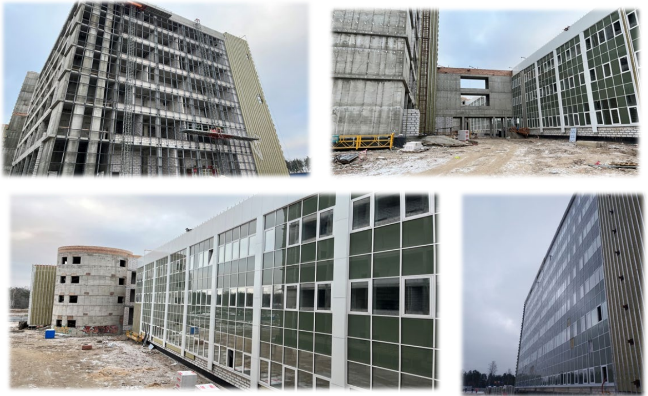
Строительство многофункционального научно-хранительского центра МАЭ РАН
