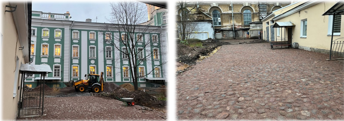
Ремонт двора МАЭ РАН
