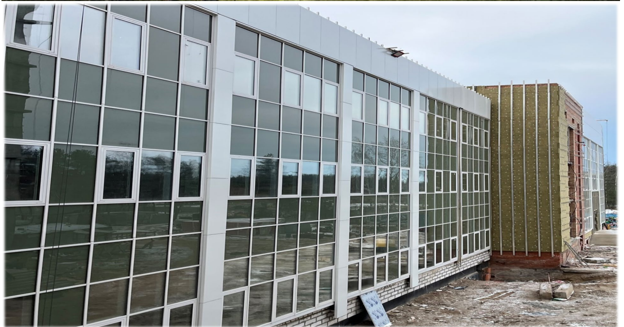
Проект и строительство многофункционального научно-хранительского центра МАЭ РАН
