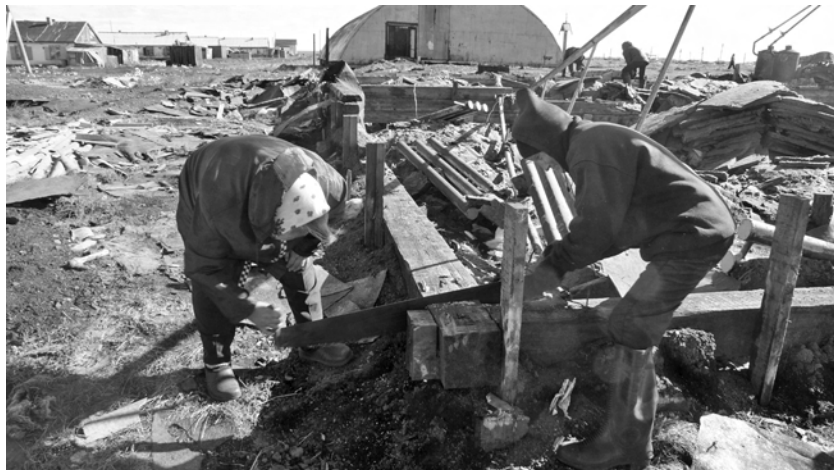
Рис. 4. Демонтаж здания. Новорыбное. Июль 2015 г. Фото автора
