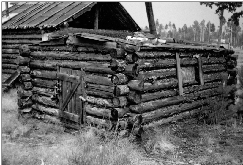
Рис. 5. Жилая срубная постройка с двускатной крышей на коньковом стояке на стойбище № 1. Река Таз. 2004 г. Фото автора
